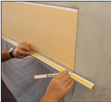
1. Profil 37428 anzeichnen oder einmessen
