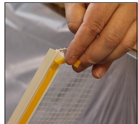
6. Den überstehenden Abdeckliner zu einer Schlaufe legen
