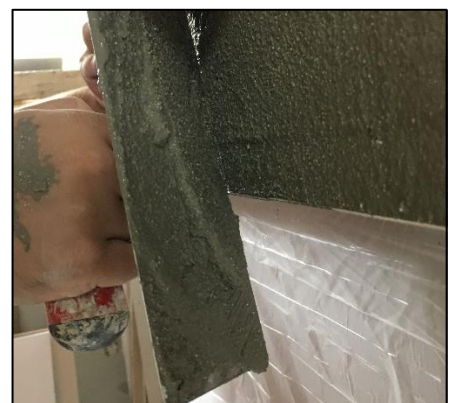
12. Zur optimalen Einbettung des Putzschenkels kann der Grundputz auf der Profilvorderkante abgezogen werden
