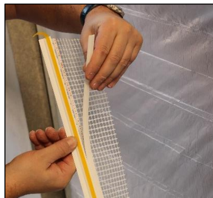
5. Den hinteren Profiltail abbrechen
