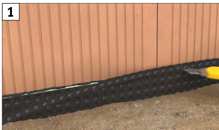
1 Noppenbahn gerade abschneiden
