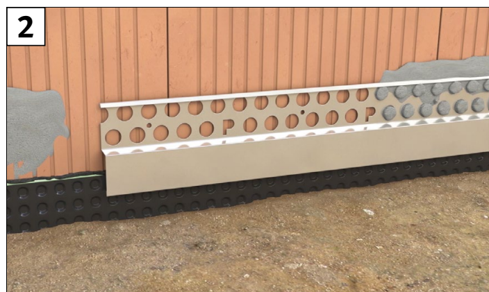
2 Profil oberhalb der Noppenbahn mit Ansetzbatzen fixieren
