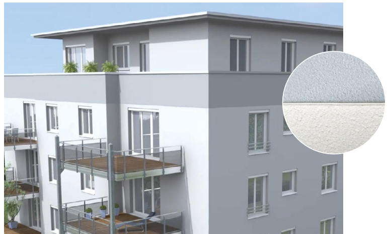
Gleitlagerfuge entlang der oberen Geschossdecke
